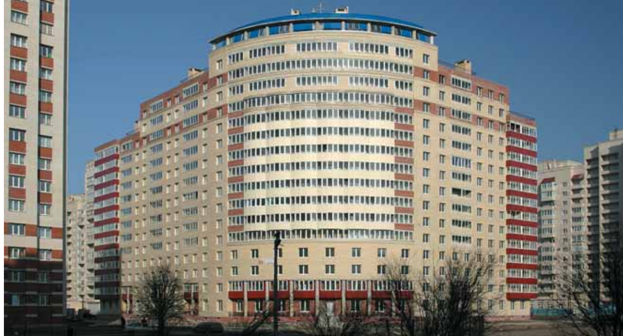
Жилой комплекс «Финский бриз» на Морской набережной
