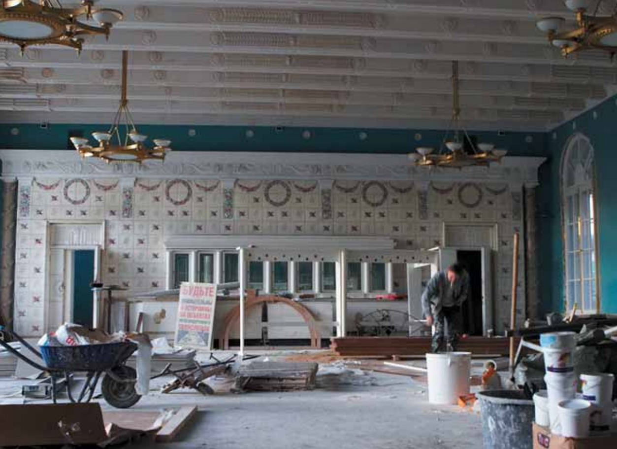
Реставрация Императорского павильона вокзала
