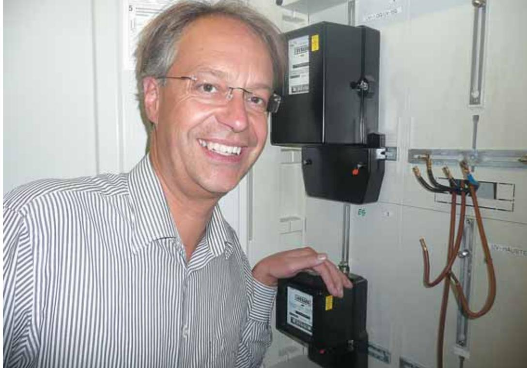
В доме два счетчика: один для потребляемой энергии, другой — для выработанной с помощью солнца
