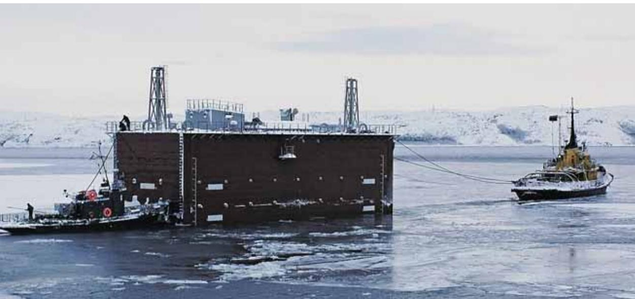
Транспортировка наплавного блока Кислогубской ПЭС к месту эксплуатации. 2006 г.
